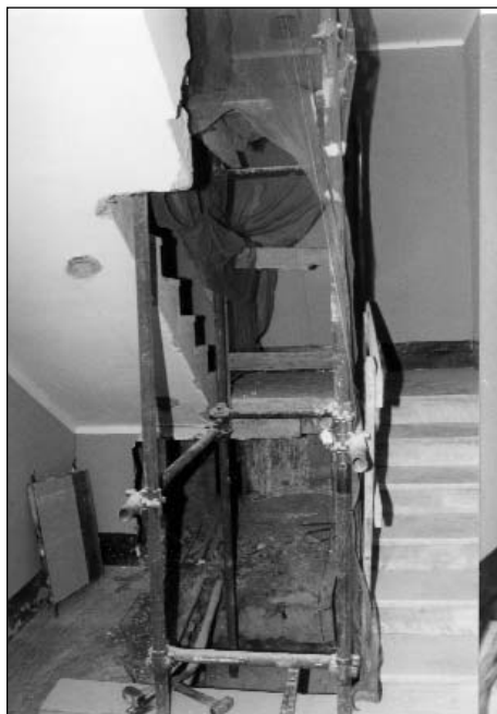
Foto 2 - Posizionamento del ponteggio (Fotografia di Marco Biffani)
