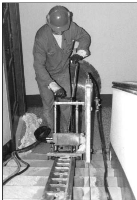
Foto 3 - Fissate le guide alla scala, la sega rotativa è in condizione di poter effettuare un preciso e netto taglio. Sullo sfondo è visibile un disco di circa 1 m di diametro (Fotografia di Marco Biffani)
