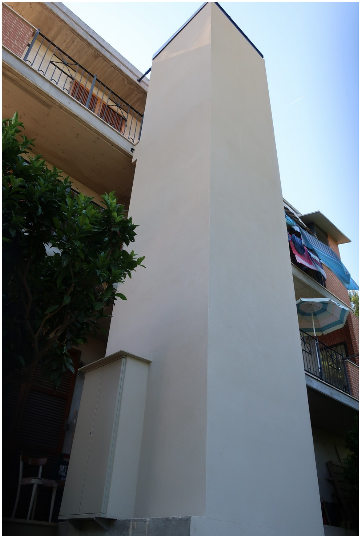
incastellatura metallica esterna con tamponatura in Aquapanel Outdoor: successiva rasatura, intonacatura e pittura seguendo l'estetica delle pareti contigue dell'edificio
