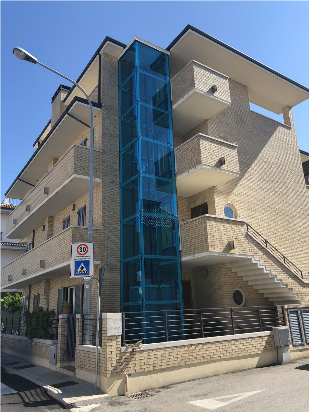
incastellatura esterna con tamponatura in vetro e porte di piano esterne all'edificio ed in vetro
