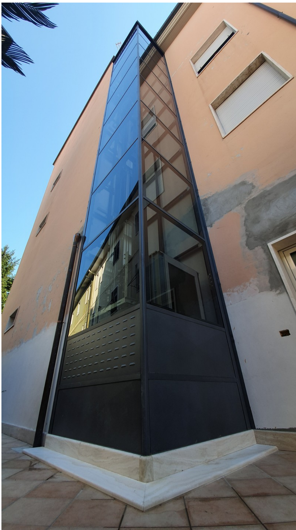
Incastellatura esterna con tamponatura in vetro e porte di piano interne all'edificio ed in vetro
