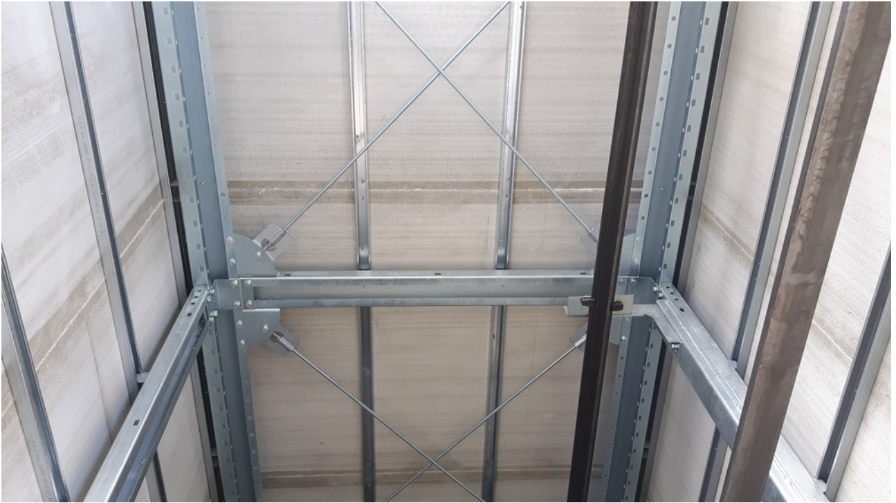
incastellatura esterna zincata a caldo con tamponatura in Aquapanel Outdoor
