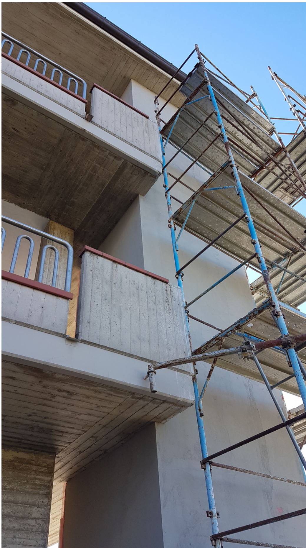
incastellatura metallica esterna con tamponatura in Aquapanel Outdoor: successiva rasatura, intonacatura e pittura seguendo l'estetica delle pareti contigue dell'edificio
