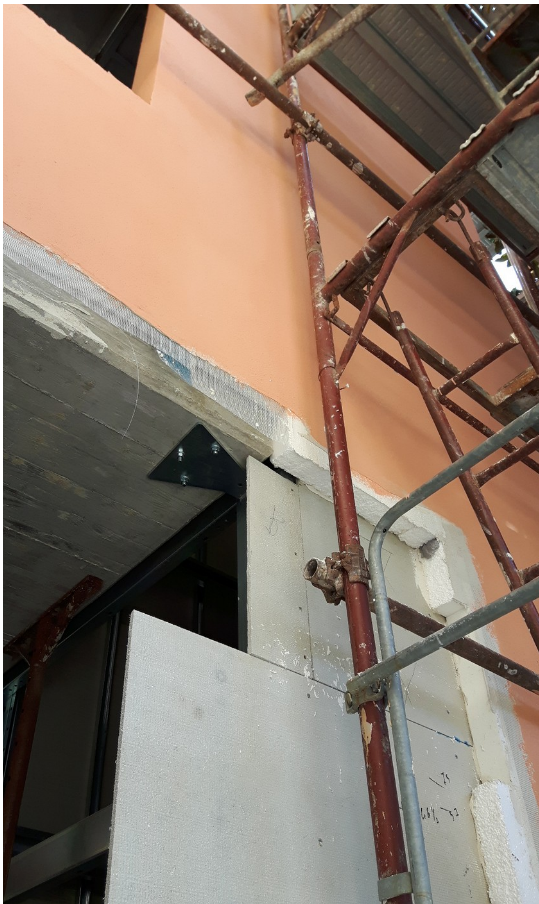
incastellatura esterna con tamponatura in Aquapanel Outdoor: interposizione di pannelli isolanti per cappotto termico prima della rasatura, intonacatura e pittura del vano ascensore
