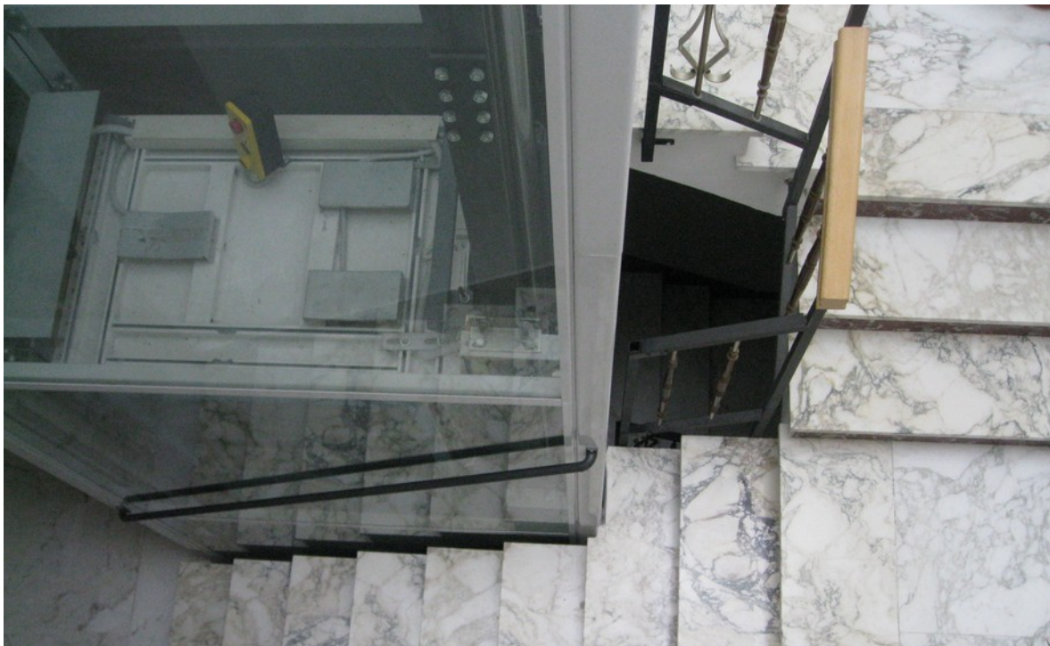
incastellatura interna con tamponatura in vetro e taglio scala
