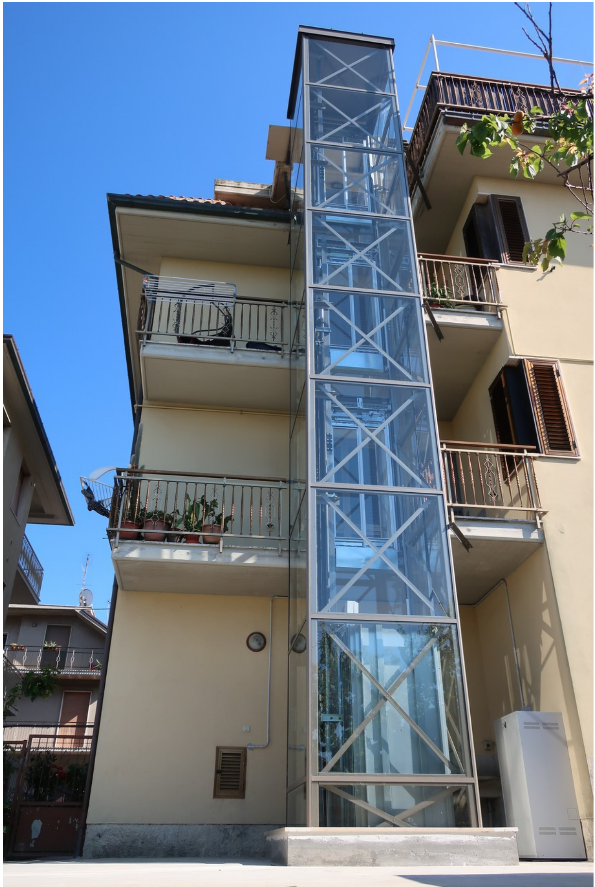
incastellatura esterna con tamponatura in vetro e porte di piano esterne all'edificio ed in vetro
