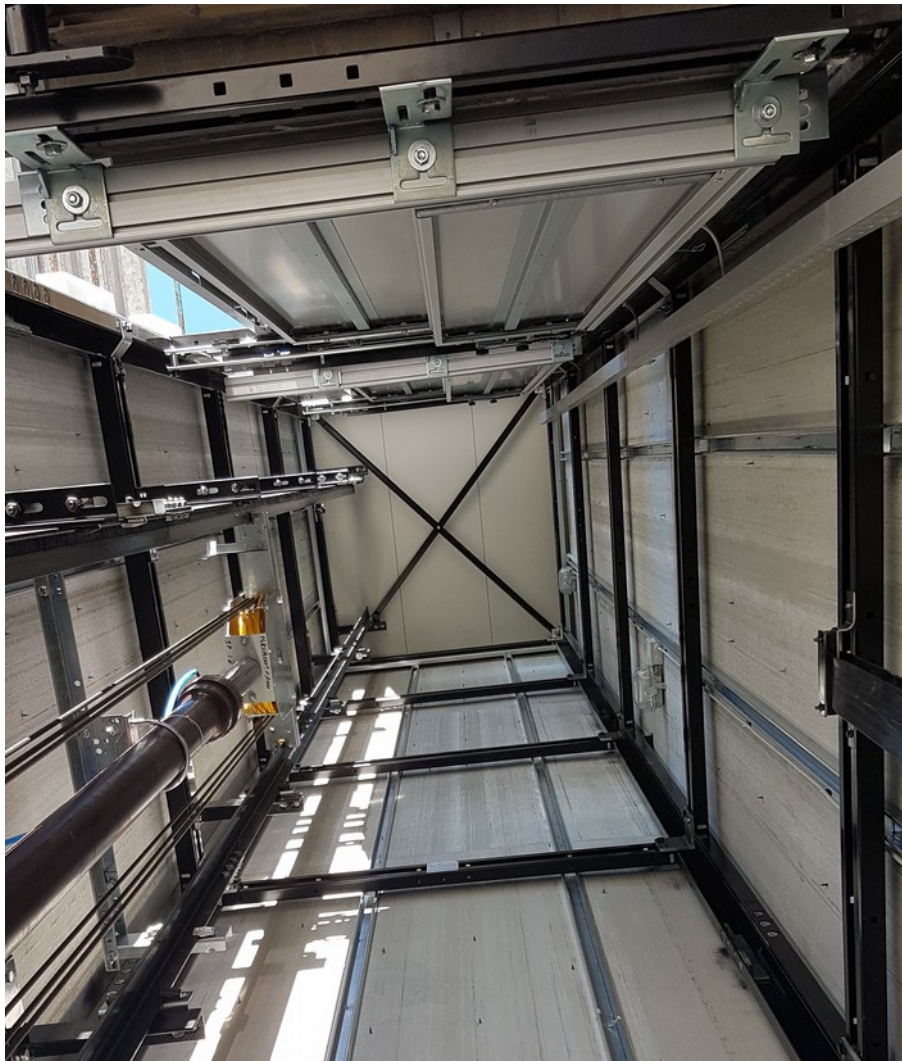
incastellatura esterna verniciata a fuoco con tamponatura in Aquapanel Outdoor
