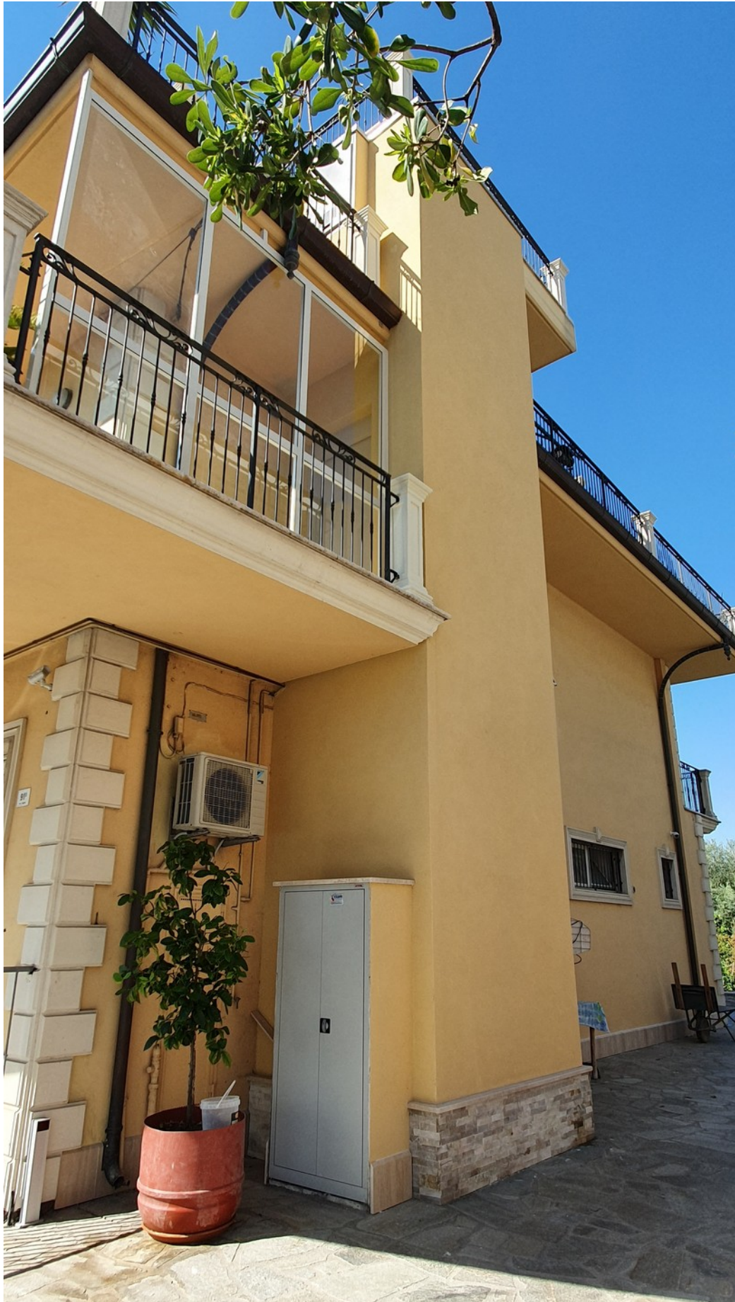
incastellatura metallica esterna con tamponatura in Aquapanel Outdoor: successiva rasatura, intonacatura e pittura seguendo l'estetica delle pareti contigue dell'edificio; porta del piano 1 esterna ma protetta dalle intemperie mediante pannellatura laterale in vetro
