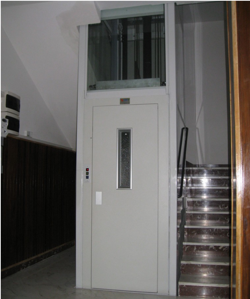
incastellatura interna con tamponatura in vetro e taglio scala
